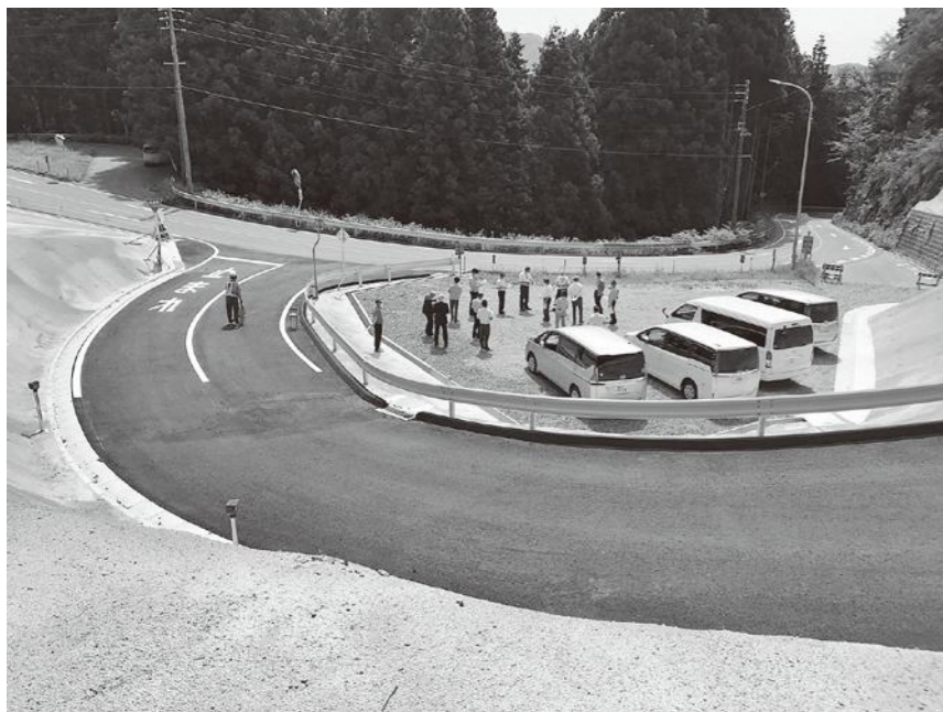
町道川向大名倉線改良工事 ▲
